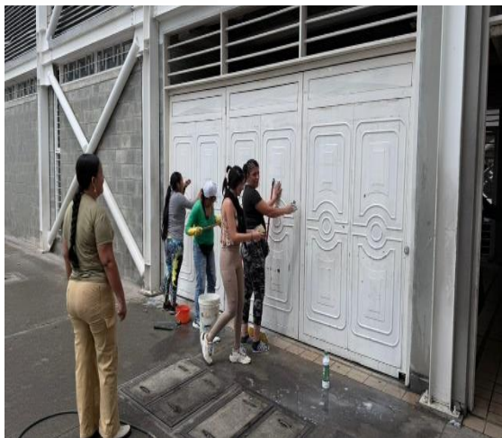
Equipo de pintura afueras de la institución.
