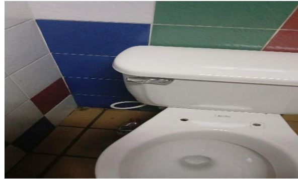
Cambio de manguera y palanca sanitaria.
