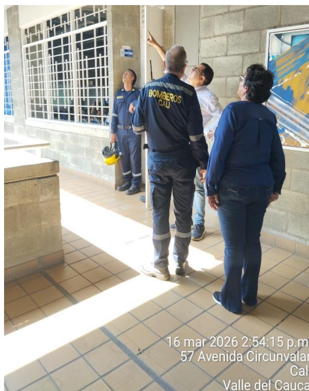
Imagen: Visita de los Bomberos para inspeccionar riesgo por abejas o avispas.
